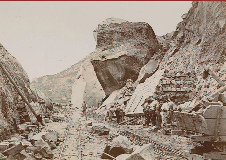
Chantier dans les grès d'Annot, début XX ème siècle. Cliché J. Gilleta, coll. G.E.C.P.
